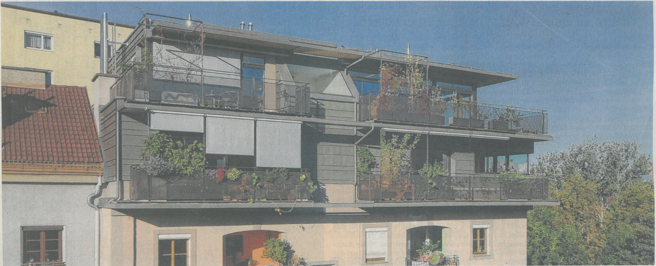
Drei Wohneinheiten mit jeweils großzügigen West-Terrassen bilden heute den krönenden Abschluss des Mehrfamilienhauses am Inn.
