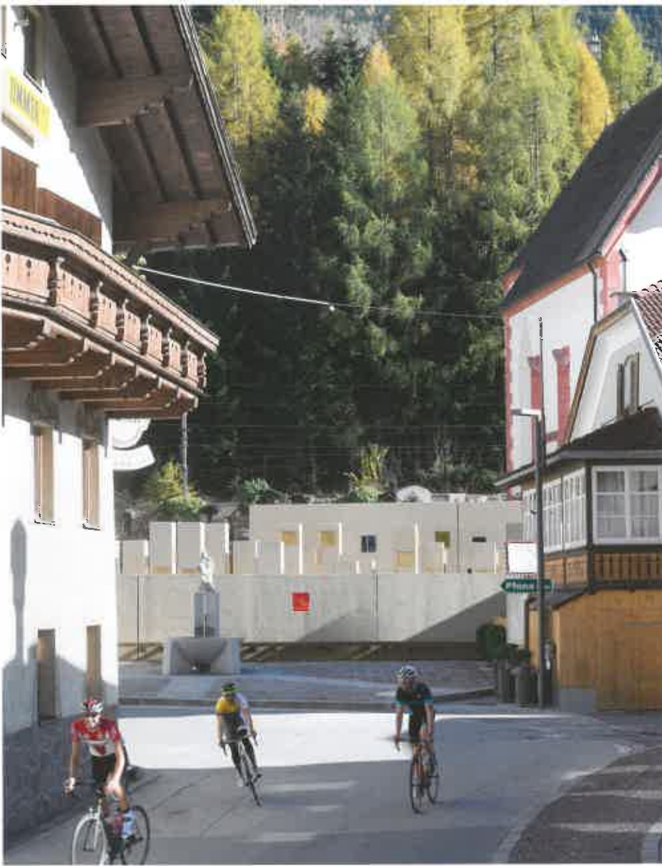
Die Urnenwand, die Stelen und Betonplatten der Erdgräber bilden einen neuen kontemplativen Ort, davor liegt der Dorfplatz mit Brunnen. The niches in the wall, the pedestal-like steles and the graves, that are set in the ground create a new contemplative space, village square with fountain in front.
